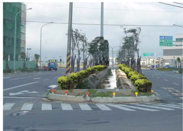
■ 道路留設灌溉水路，維持水圳之連通。
